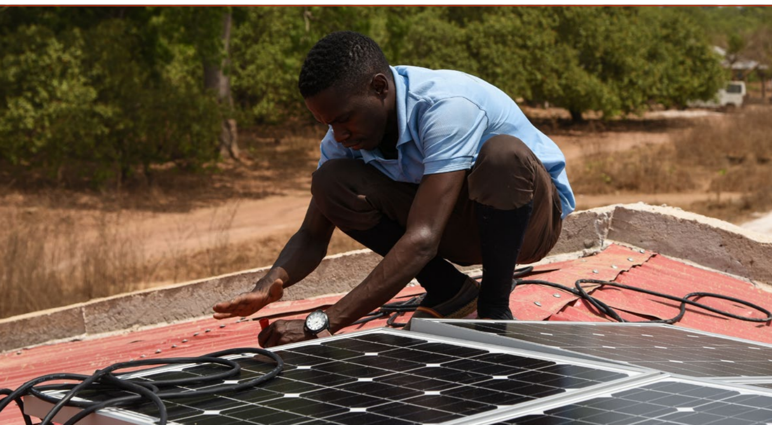
Figura 1: Instalação de um sistema solar caseiro pela FRES.
