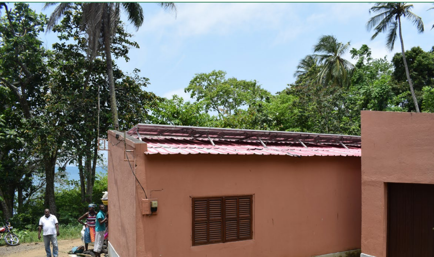
Figura 1: Instalação do sistema solar fotovoltaico na sede da Associação.
