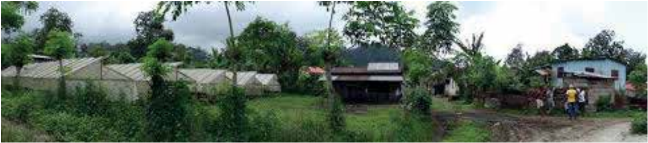
Figura 38 Fotografia do projecto de instalação de sistemas PV em 11 comunidades e cooperativas agrícolas / Fonte: TESE, 2015
