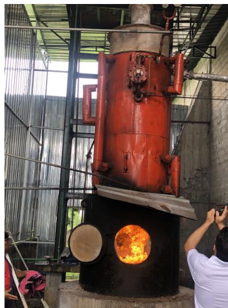
Figura 10 – Caldeira a biomassa a casca de coco (noz) | Valudo, 2022
